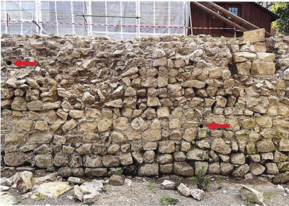
15: Ansicht der östlichen Umfassungsmauer mit Gerüstlöchern (Pfeile) und stärker ausgewaschenem Mörtel in den untersten drei Steinlagen. Die Mauer ist in diesem Abschnitt maximal 2,5 m hoch erhalten. Foto vom Mai 2022.
